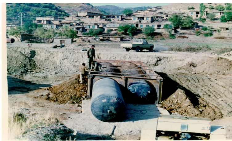
پل بتنی با قالب تیوپی لوله‌ای
