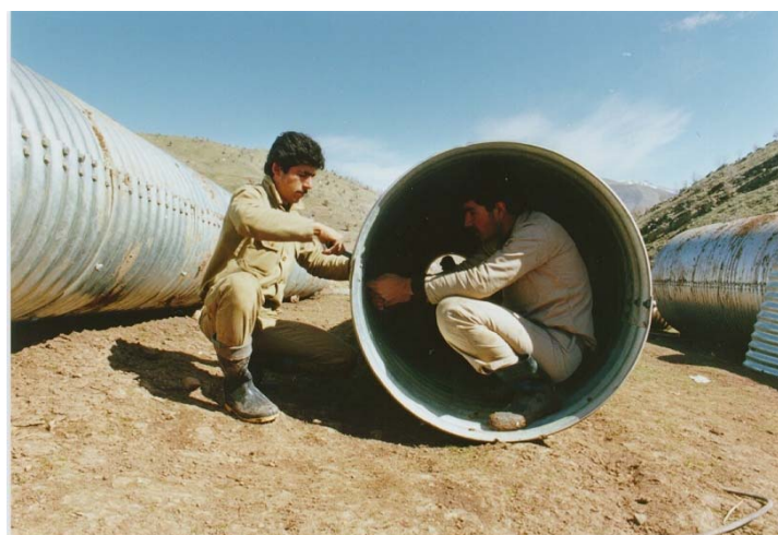
مونتاز لوله‌های آرمیکو جهت احداث پل‌های لوله در والفجر ۹
