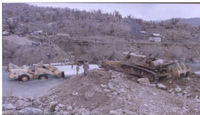
احداث پل لوله ای و جاده در منطقه عملیاتی والفجر ۹ (شیلر)
